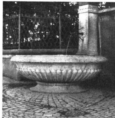
Abb. 5 (unten) / Brunnen (errichtet 1837) gegenüber dem Hause zum Kronentor (Abb. 4) in Achse des früheren Hauseingangs
