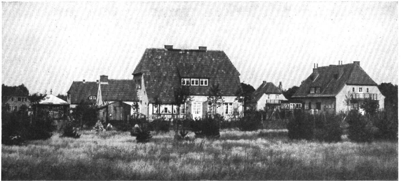
ABB. 3 / EIN- UND ZWEIFAMILIENHÄUSER IN GARTENVORSTADT EIGENHERD / ARCHITEKT: W. VON WALTHAUSEN
