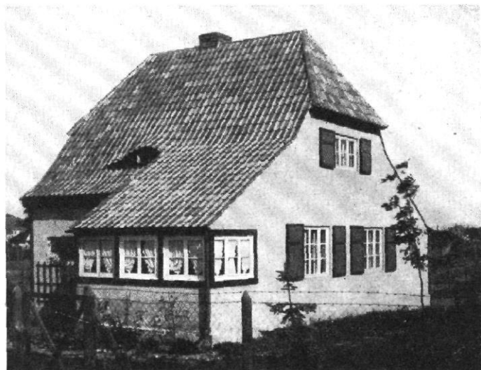
ABB. 35—37 / EINFAMILIENHAUS (MIT STALL- UND VERANDA-ANBAU) IN „EIGENHERD“. ANSICHT NEBST ZWEI GRUNDRISSEN ARCHITEKT: W. VON WALTHAUSEN
