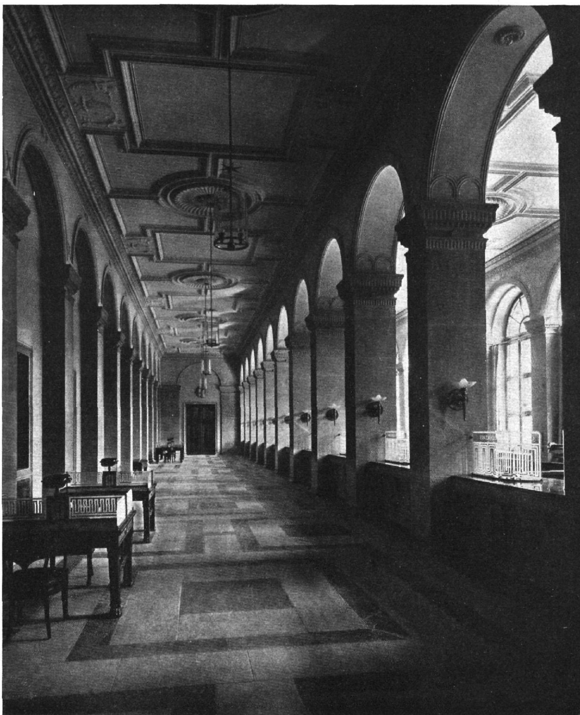
ABB. 7 / DIE SCHALTERHALLE SCHWEIZERISCHE NATIONALBANK, ZÜRICH / ARCHITEKTEN: GEBRÜDER PFISTER
