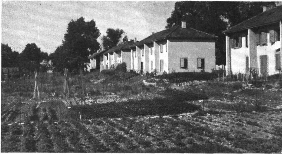
ABB. 5 / RÜCKSEITEN DER DREIACHSIGEN HÄUSER UND HAUSGÄRTEN (VGL. ABB. 6, UNTEN; ABB. 12, S. 359; AUCH ABB. 1, S. 333)
