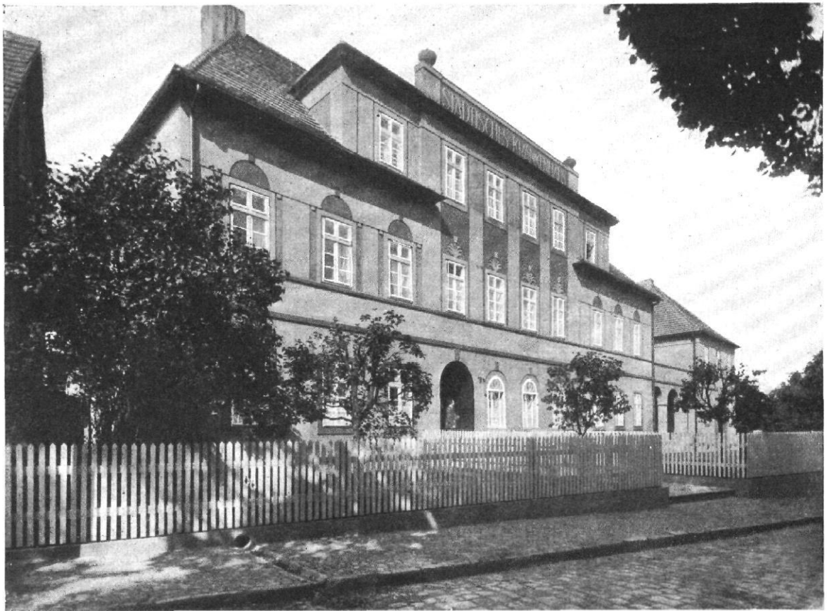
SECHSFAMILIENWOHNHAUS UND VERWALTUNGSGEBÄUDE DER WUNDERLICH A. G., ALTWASSER, SCHLESIEN ARCHITEKT: ERNST PIETRUSKY
