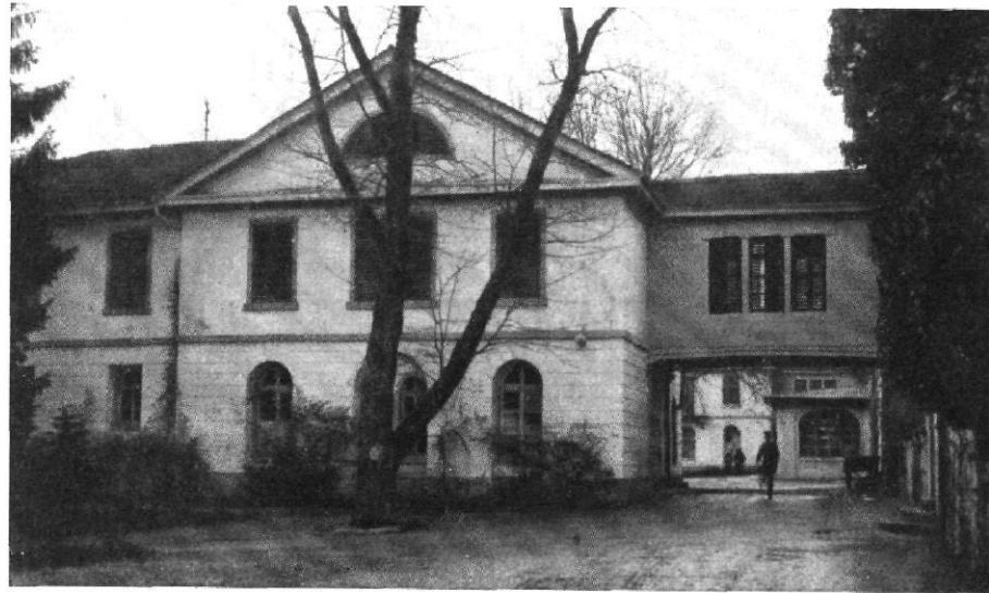
Abb. 12 / Blick von Süden gegen den Eckbau und die Durchfahrt
