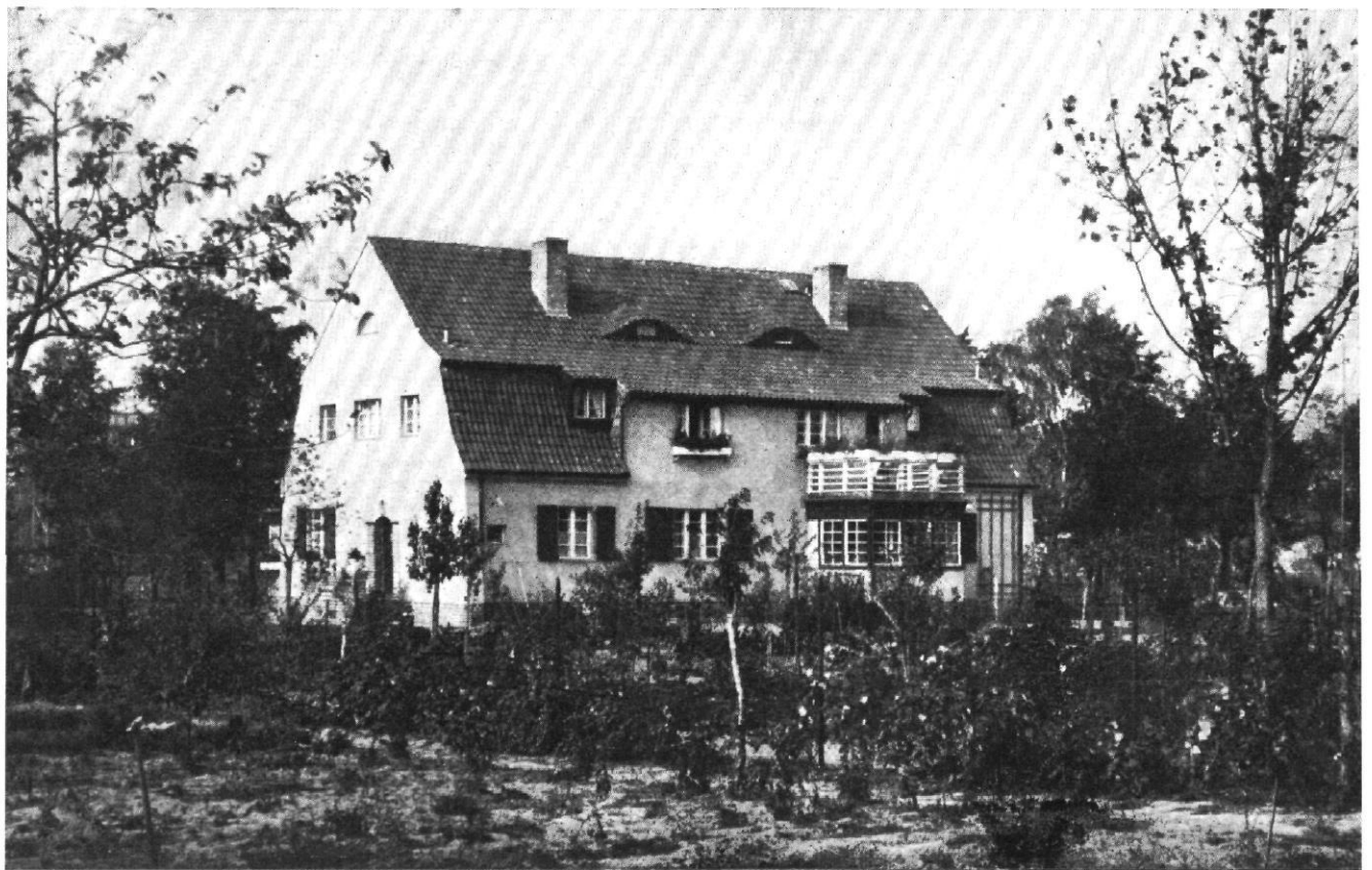
ABB. 46 / VIERFAMILIENHAUS IN NEUBABELSBERG. ANSICHT VOM GARTEN. VGL. ABB. 42 UND 43. ARCHITEKT: WERNER VON WALTHAUSEN
