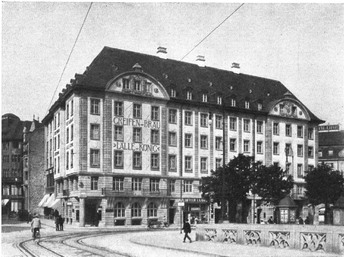
ABB. 34 / DREI GESCHÄFTSHÄUSER AN DER SCHIFFLÄNDE, BASEL
