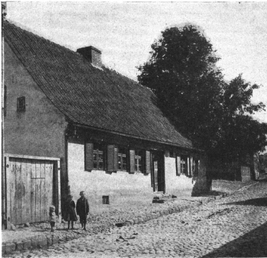
Altes Wohnhaus in der Bergstraße in Goldap, Ostpr. Erhalten geblieben
