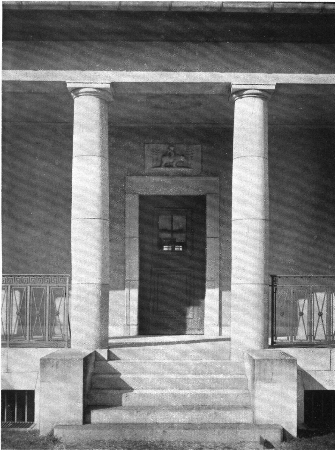
Abb. 38. Krankenhaus E. Mittlerer Bauteil. Detail
