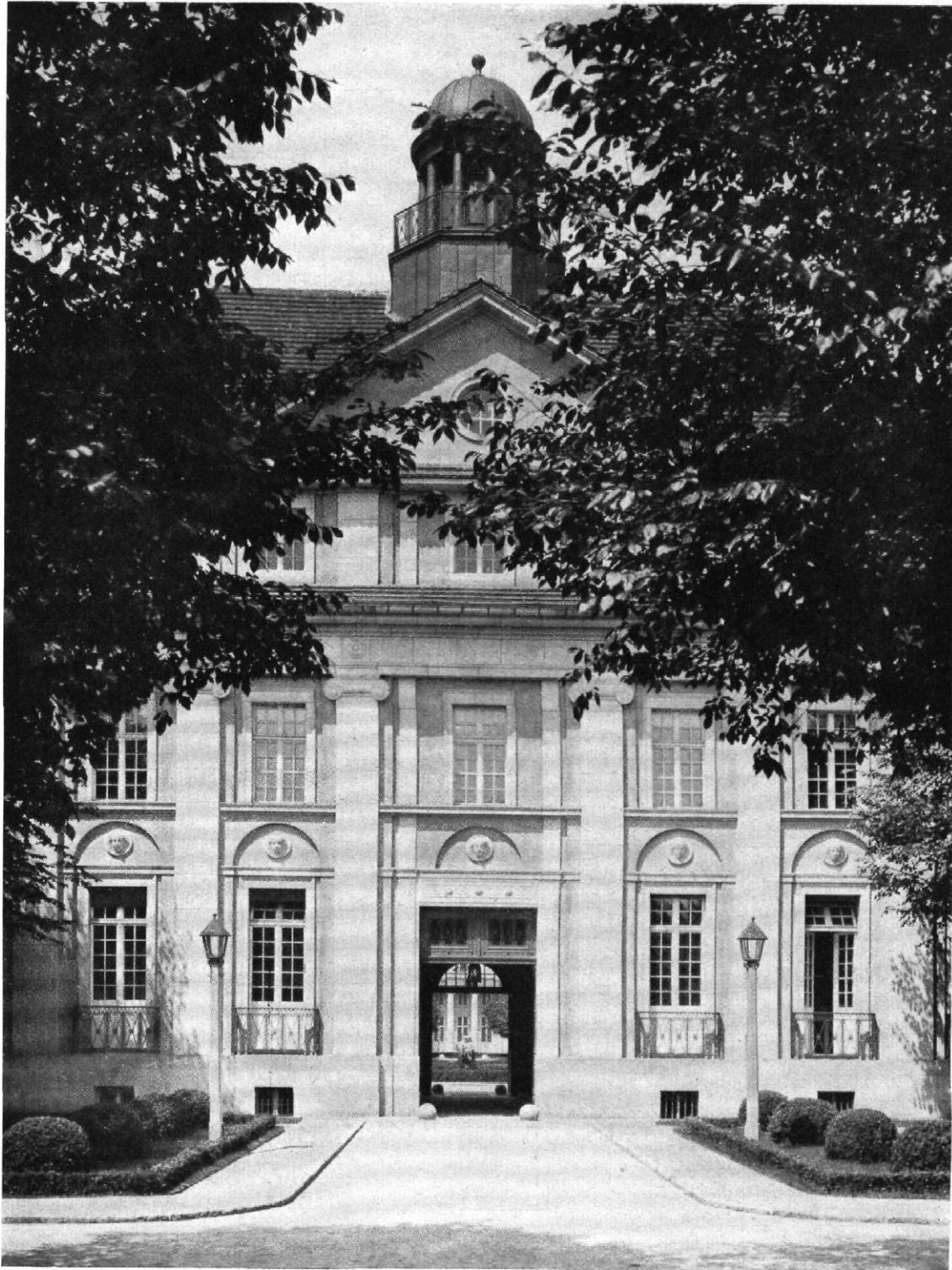
Abb. 10. Verwaltungsgebäude. Vorderansicht. Mittelbau
