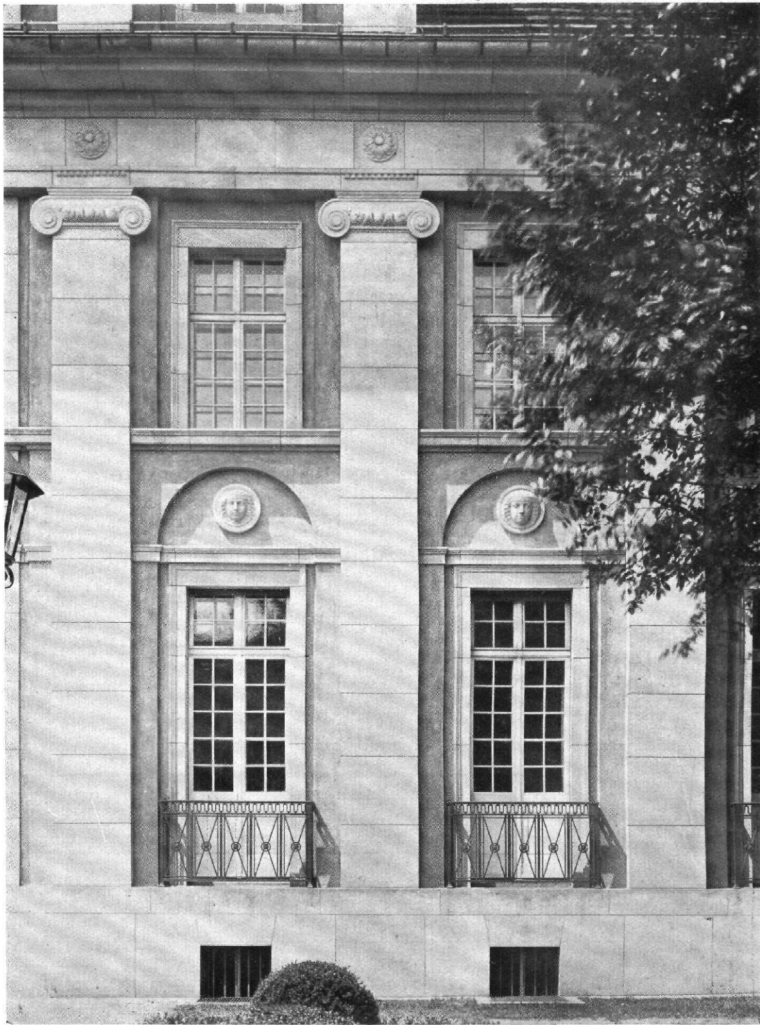
Abb. 12. Verwaltungsgebäude. Vorderansicht. Detail
