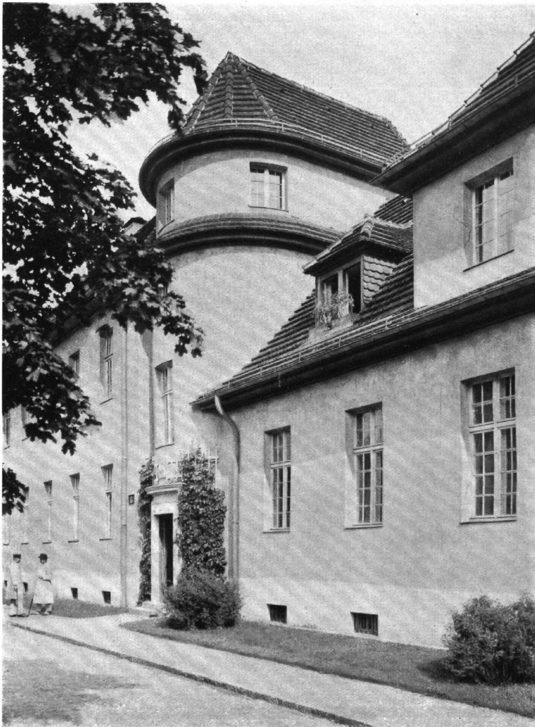
Abb. 42. Krankenhaus E. Mittelbau. Rückansicht. Teilbild
