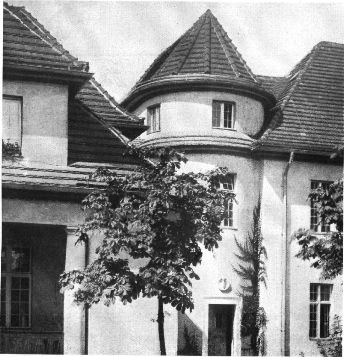
Abb. 34. Krankenhaus E. Verschneidung der Dächer
