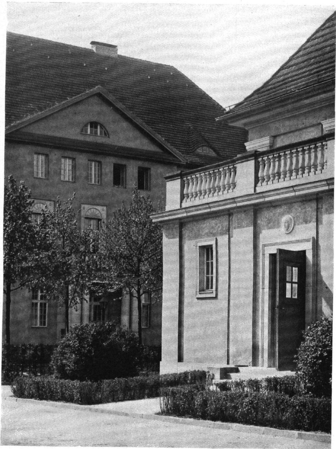
Abb. 23. Unterhaltungshaus. Teilbild. Blick nach dem Krankenhaus E
