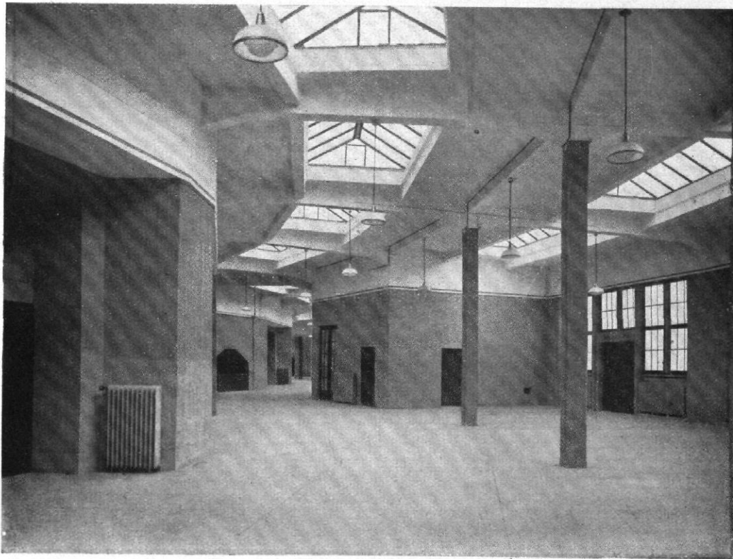
Gürtelbau im Innern
