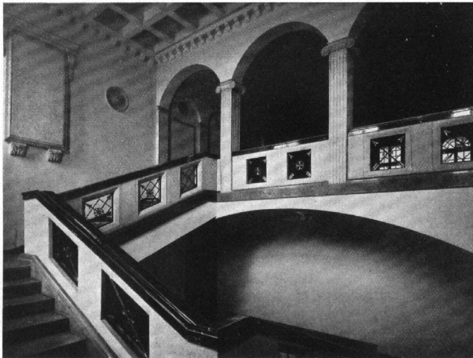
Treppenhaus im Verwaltungsgebäude
