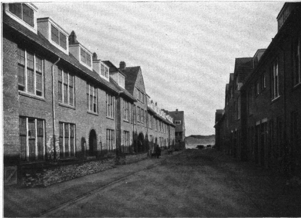
Blick von Standpunkt F des Lageplanes
