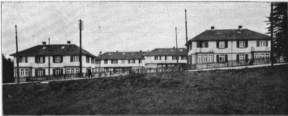
Einfamilienhaus-Kolonie Rehalp, Zürich Gesamtansicht gegen Süden
