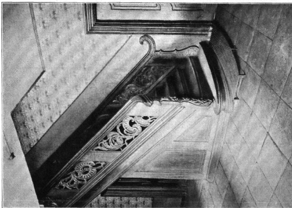
Barmen, Unterdörnerstr. 74 Dielentreppe
