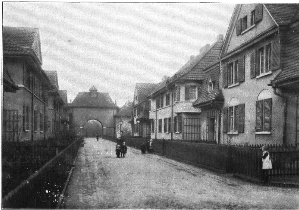
Blick 3 des Lageplanes — Blick in eine Wohnstraße
