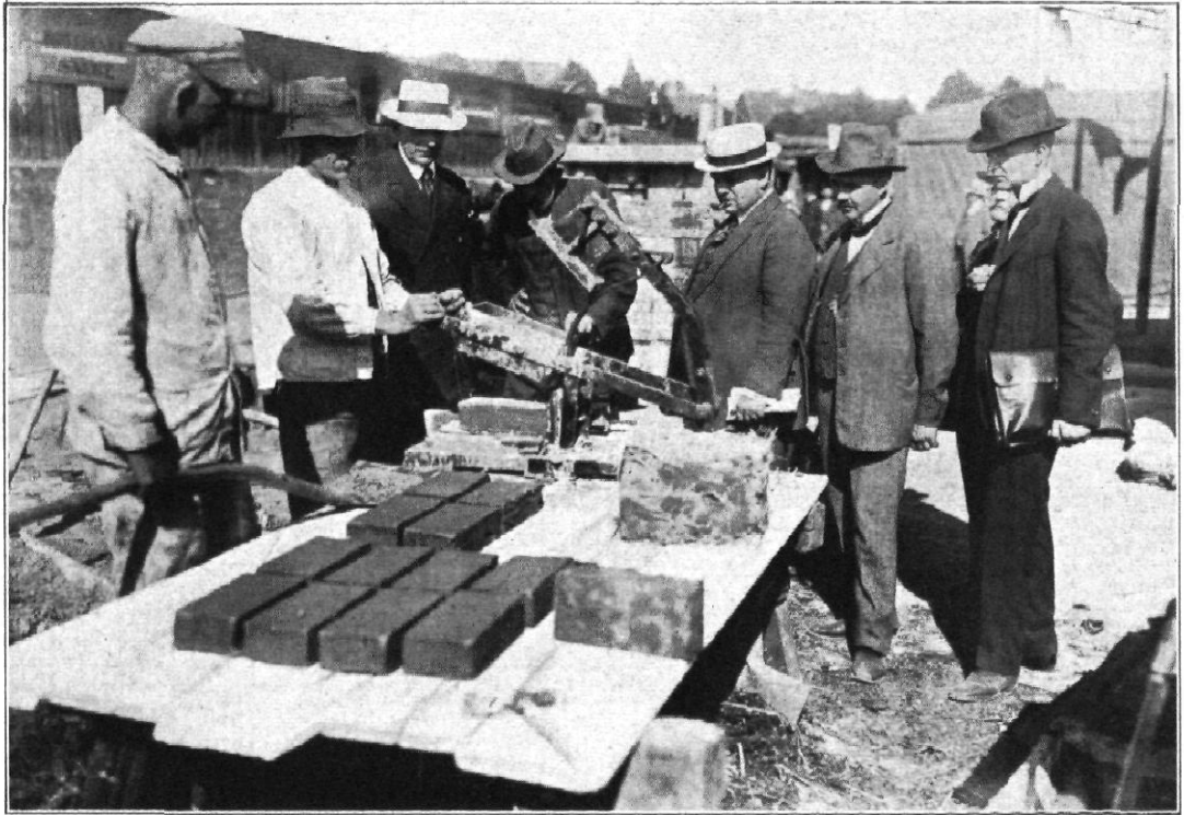
Neue Bausteine aus Lehm und Stroh Vorführung der Fabrikation auf der Wanderausstellung in Magdeburg
