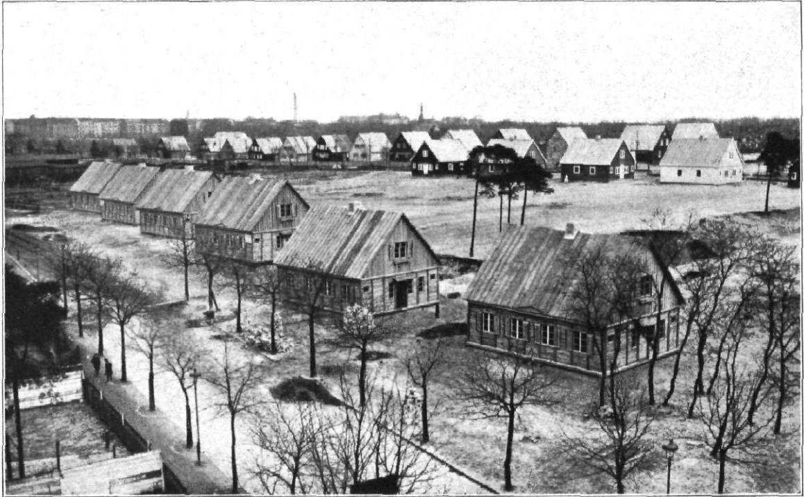
Holzhaus-Siedlung Steglitz (Wohnungs-Verband Groß-Berlin)
