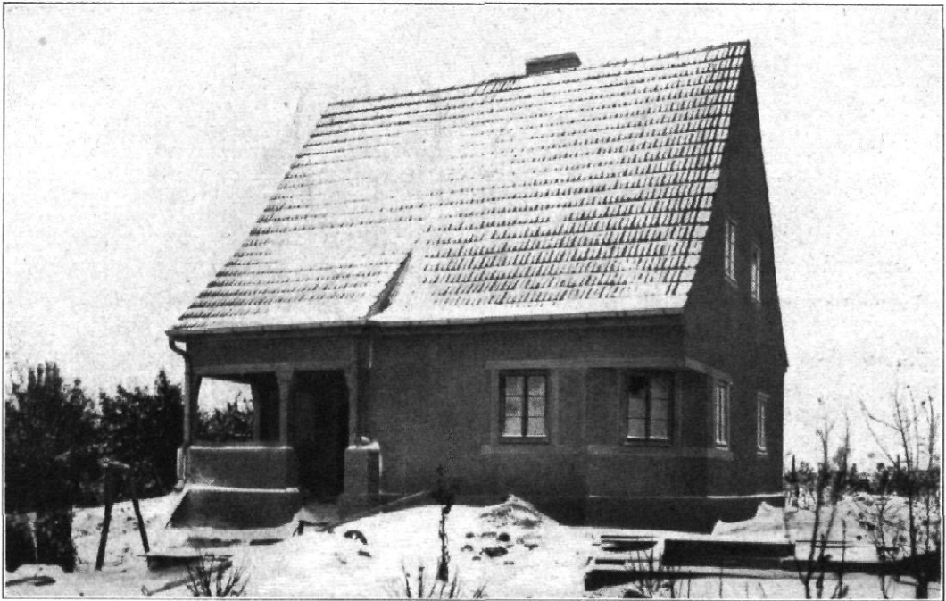
Lehmhaus in Kaulsdorf nach Fertigstellung (Ausführung: Härtel - Baugesellschaft)
