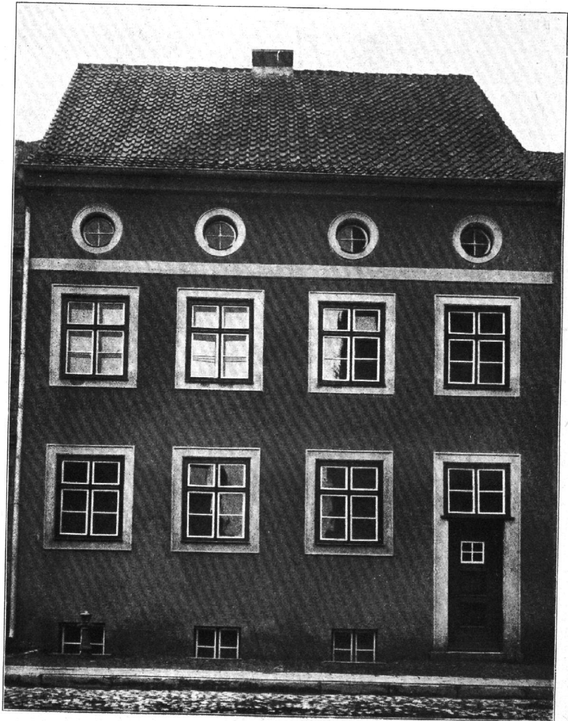
Hans J. Philipp, Architekt, B. D. A. Goldap, Ostpr.: Wohnhaus Matthes Rogowski in Goldap, Ostpr. Töpferstraße
