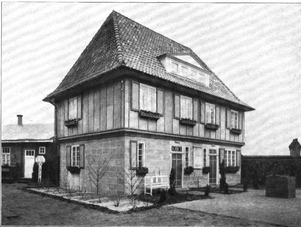
Hermann Muthesius, Architekt, Nikolassee: Arbeiterdoppelhaus auf der Ausstellung für sparsame Bauweise
