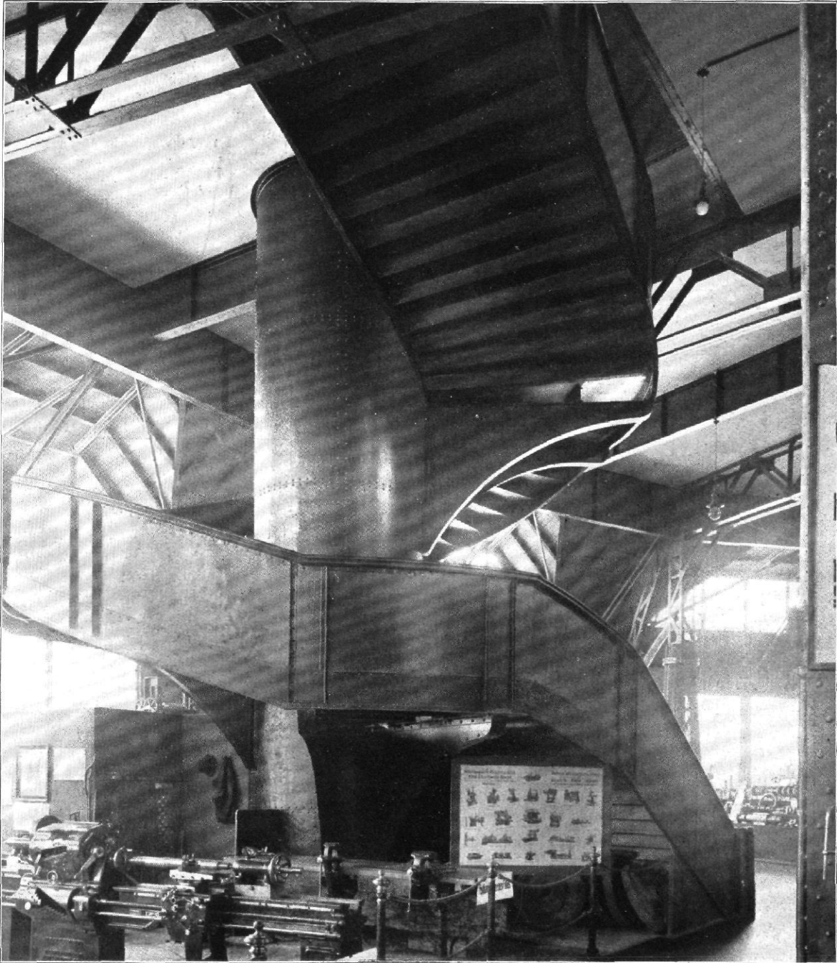
Hans Poelzig, Architekt, Dresden: Wasserturm für Posen Treppe zur Empore in der unteren Halle
