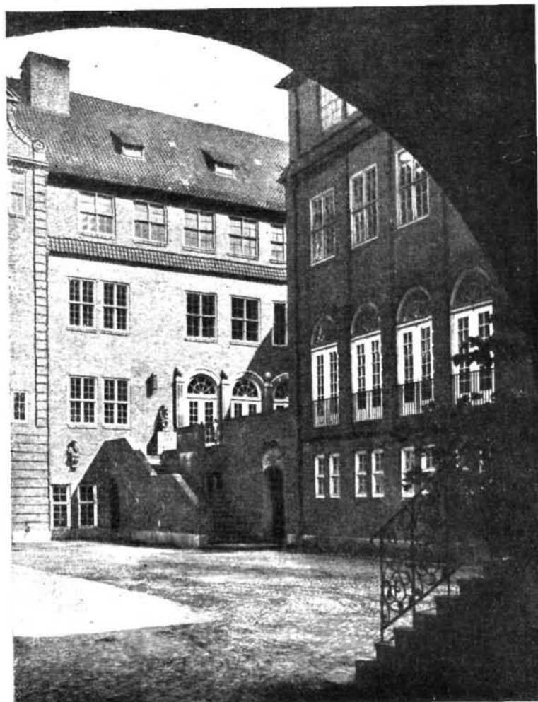
Abb. 17. Innenhof, Ostseite gegen den Schmuckhof.
