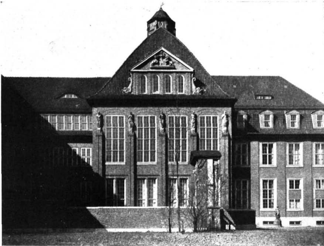
Abb. 8. Teil der Südansicht mit kirchlichem Raum und Bibliothek.
